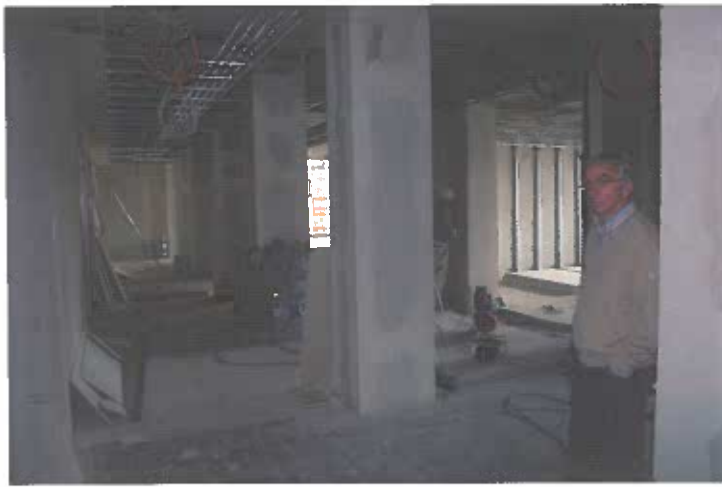
Rückbau des Lehrerzimmers
