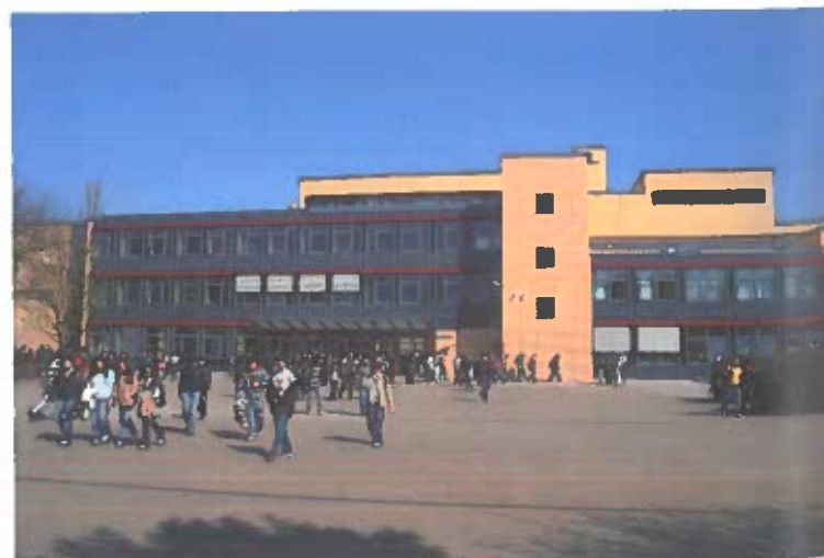
Die rückgebaute Fassade
