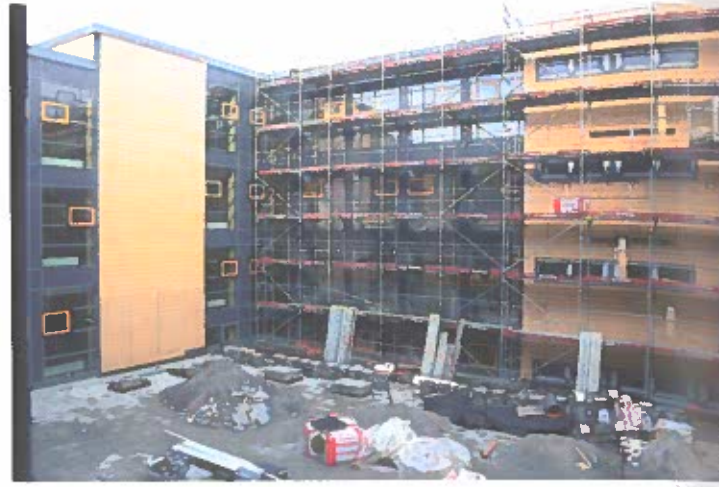
Rückbau der Fassade im Innenhof
