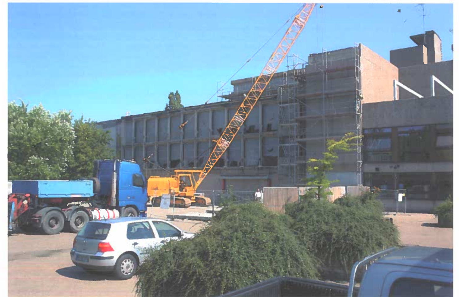
Demontage der Betonplatten am naturwissenschaftlichen Trakt
