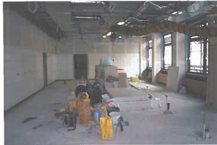
Rückbau der Lehrküche
