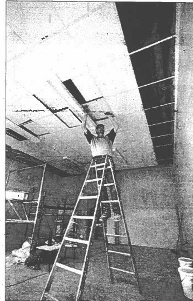
In der Mensa entstehen vier Klassenräume - durch Zwischenwände, tiefer gehängte Decken, mit altem Mobiliar und neuen Tafeln.
