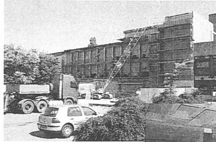
Juli 2004: „Ach, auf dieser Großbaustelle findet auch geregelter Unterricht statt?“ Erstaunt betrachten Besucher den zweiten Bauabschnitt. Der Trakt der Naturwissenschaften ist kaum wiederzuerkennen.
