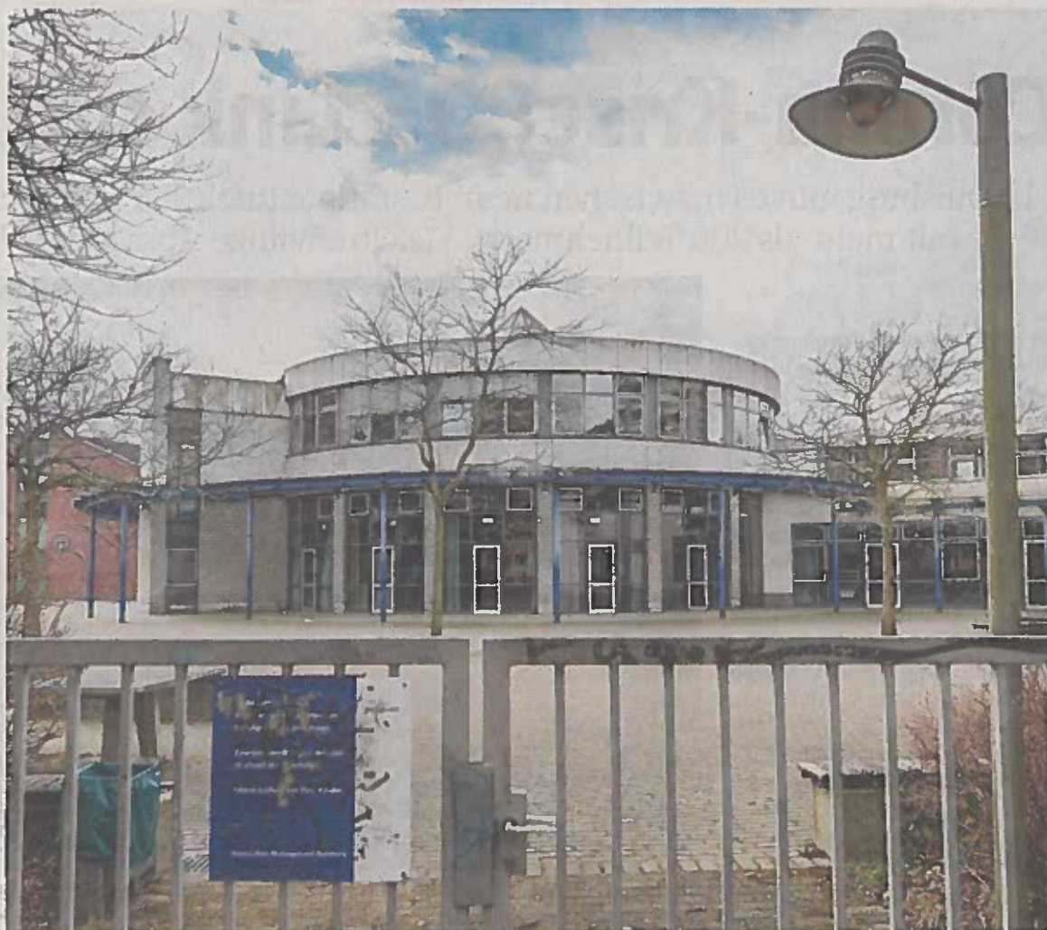
Die Bauschäden an der Erich-Kästner-Gesamtschule in Duisburg-Homberg sind nicht zu sanieren. Deshalb plant die Stadt einen Neubau auf dem RAG-Gelände an der nahe gelegenen Baumstraße. FOTO: VOLKER HEROLD / FR
